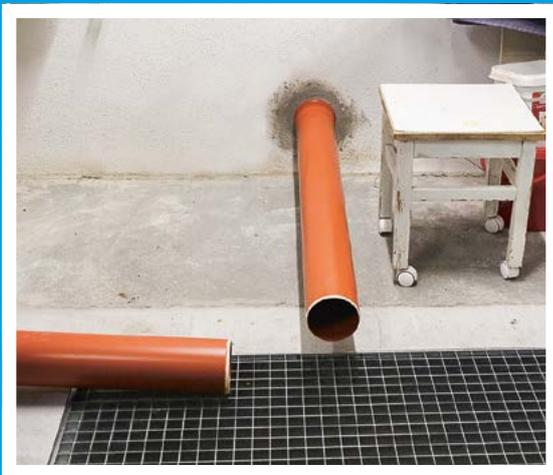
▲ Pumpensumpf mit Zulauf für Flutwasser
